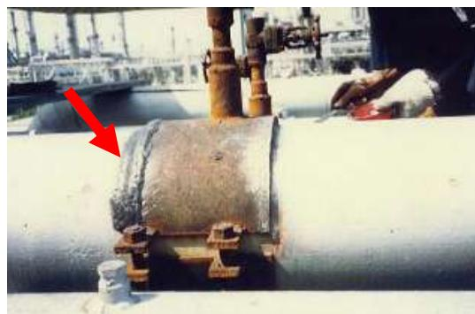
金属押出し用プロテクターの補修
