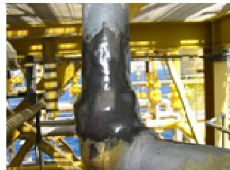
配管の油漏れを補修
